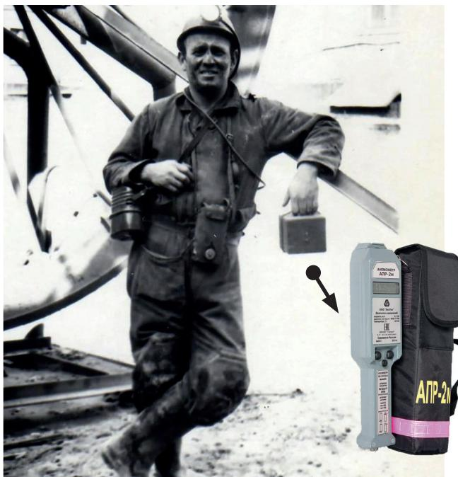
На фото 1970г в руке автора анемометр АСО-3, обеспечивающий измерения скорости воздушного потока в диапазоне от 0,3 до 5 м/с. Один из двух анемометров, имевшихся 50 лет тому назад (был еще и анемометр МС-13, используемый для измерения скорости от 1,0 до 20 м/с).
